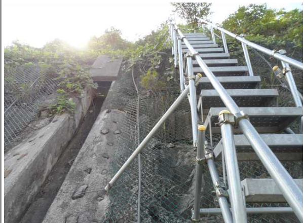
수직도수로, 점검계단 전경
