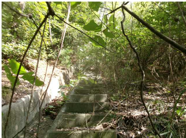
산마루측구, 점검계단 전경
