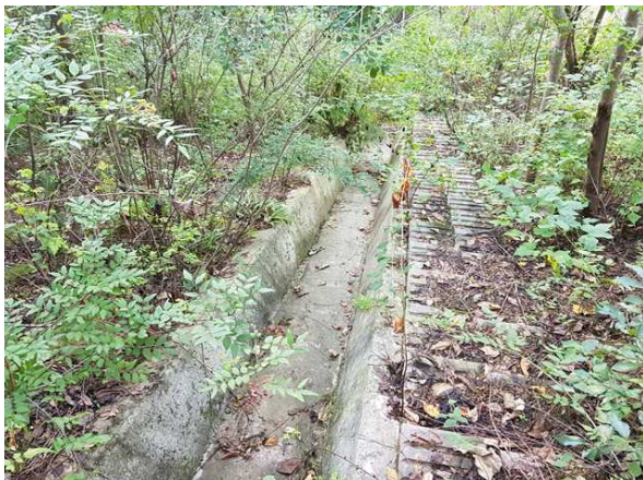
산마루측구, 점점계단 전경
