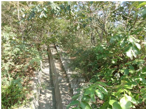
산마루측구, 점점계단 전경
