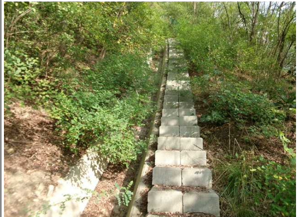
산마루측구, 점검계단 전경
