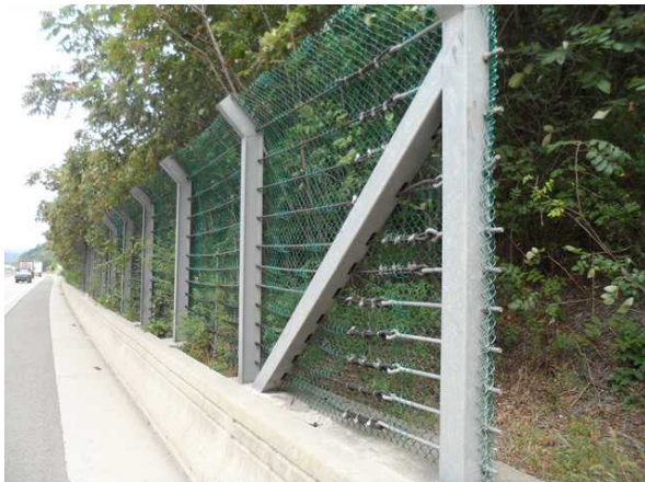
도로, 낙석방지울타리 전경
