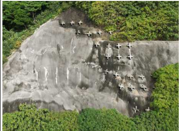
슛크리트, 격자블럭 전경
