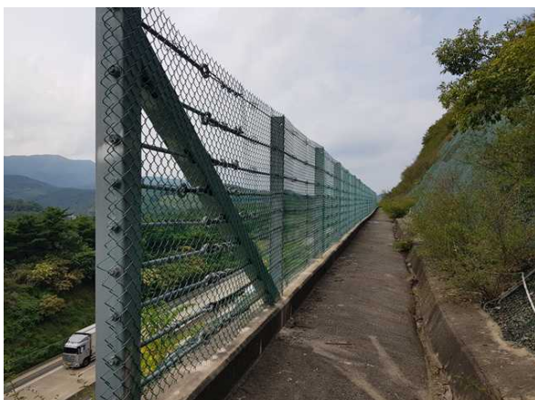
소단배수로 낙석방지울타리 전경
