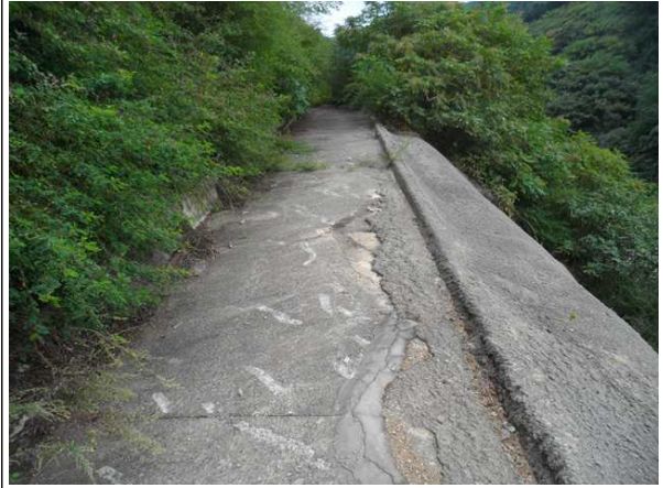
1소단 배수로 전경
