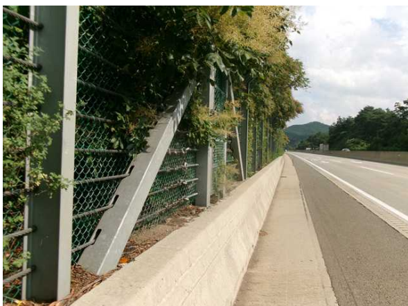
도로, 낙석방지울타리 전경
