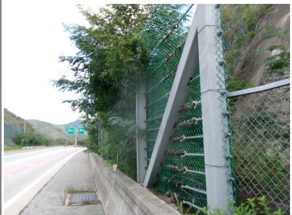
도로, 낙석방지울타리 전경
