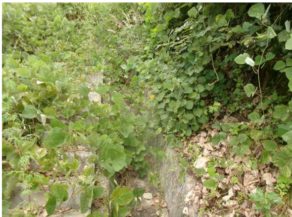
산마루측구, 점검계단 전경
