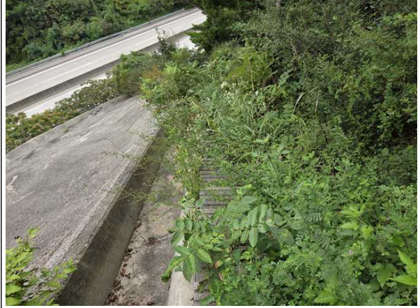
점검계단, 산마루측구 전경
