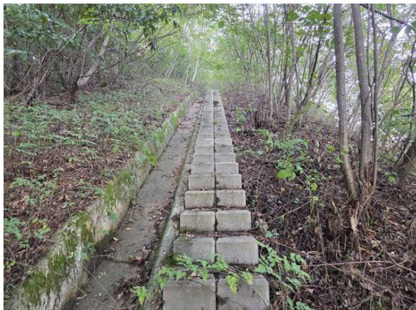
산마루측구, 점점계단 전경
