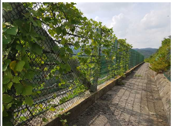
소단배수로 낙석방지울타리 전경
