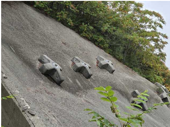
슛크리트, 격자블럭 전경
