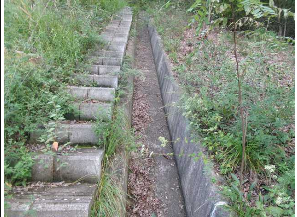
점검계단, 산마루측구 전경
