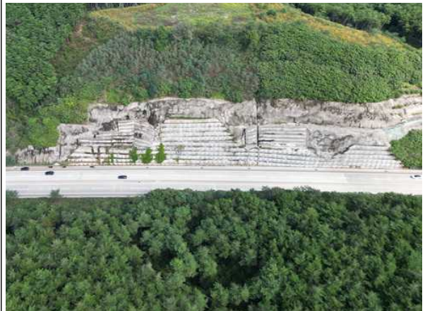
사면내 옹벽 전경
