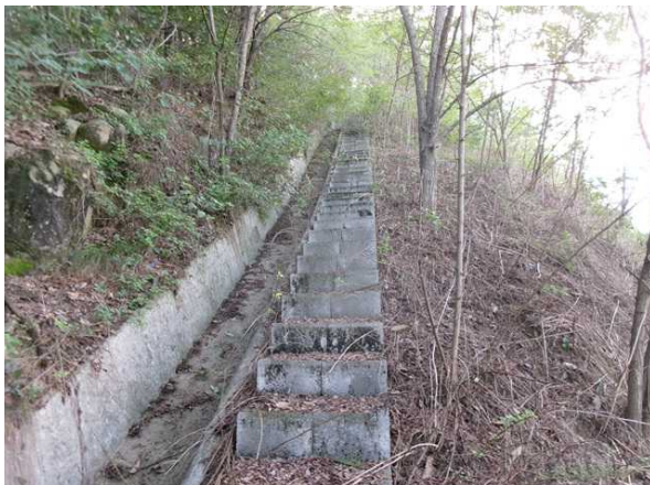
산마루측구, 점점계단 전경
