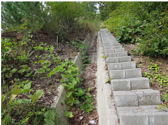
점점계단, 산마루측구 전경
