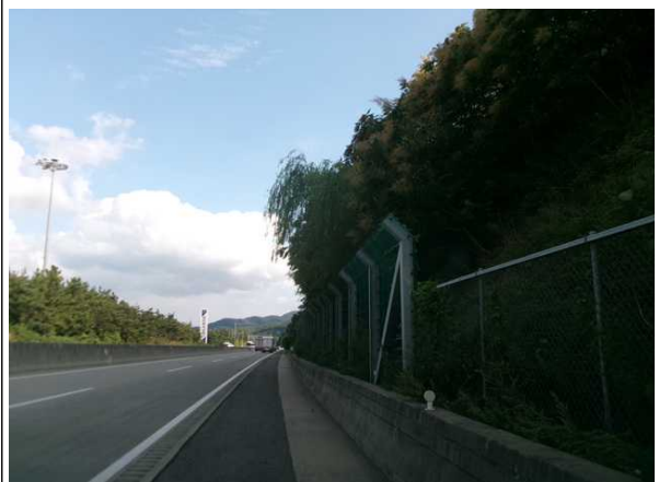
도로, 낙석방지울타리 전경
