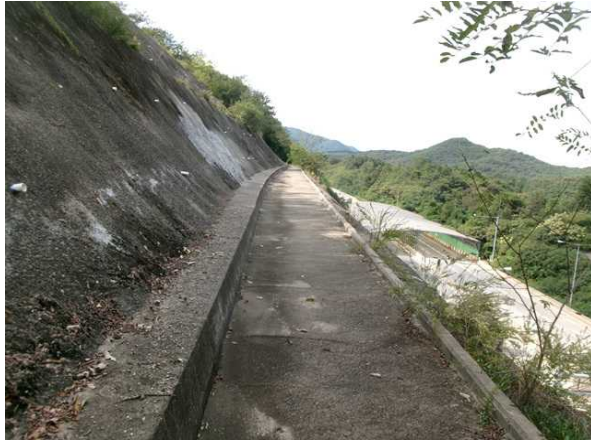
1소단 배수로 전경
