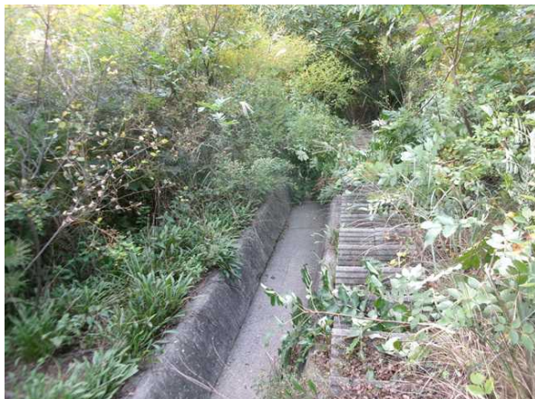
산마루측구, 점검계단 전경
